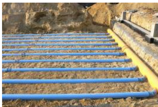
Obra intercambiador aire-tierra Awadukt Supermercado TESCO (Septiembre 2006)
