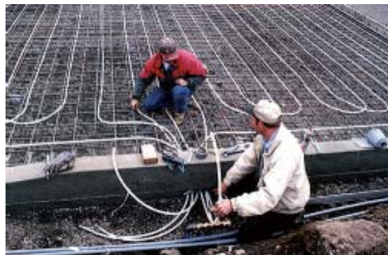
Instalación del sistema de tuberías para el sistema geotérmico de calefacción de distrito para deshacer la nieve de las aceras. Oregon. Fuente: National Renewable Energy Laboratory (Laboratorio Nacional de Energía Renovable)
