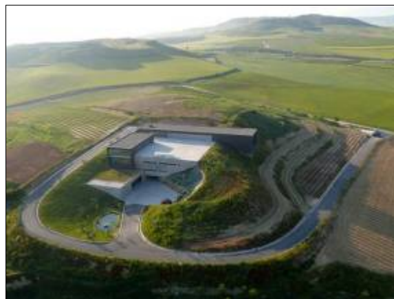
Bodega riojana donde se ha aplicado la primera instalación geotérmica en el mundo destinada a la elaboración del vino.
